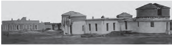
38- El antiguo edificio del Observatorio Meteorológico y Astronómico. Colectividad suiza en Córdoba.
