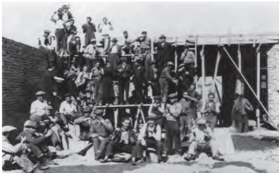
8- Construcción de la sede social de la Sociedad Lituana de Socorros Mutuos Neptunas. Imagen perteneciente a la Flia. de Miguelina Sarauskaite, S/D.
